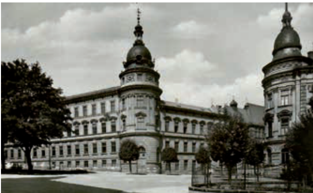
Schulkomplex, li.: Gymnasium (Wallgrabengasse), re: Knaben- u. Mädchenbürgerschule (Gelnhausengasse)
